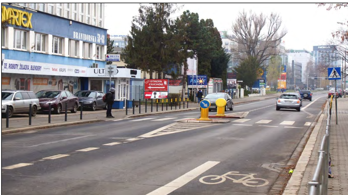
Rys. 3.3.3. Przykład zmniejszenia szerokości przekroju jezdni poprzez wydzielenie trasy rowerowej wraz z przejściem dla pieszych z zastosowaniem wyspy azylu oraz tzw. pylonów zespolonych ze znakiem C-9. Dodatkowo zastosowano odgięcie torów jazdy w celu dodatkowego spowolnienia ruchu pojazdów.
