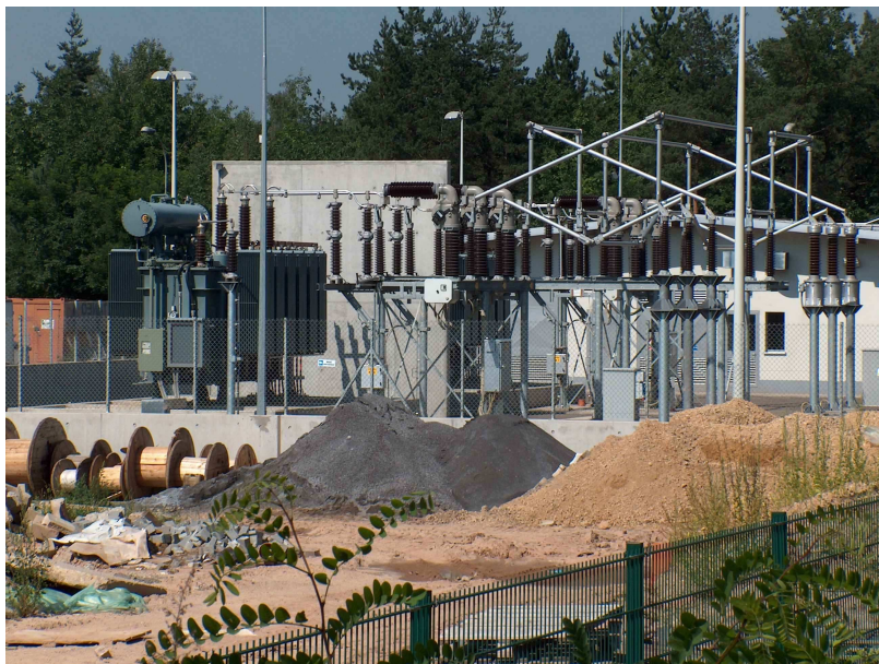
Fotografia Nr 55 Stacja rozdzielczo-transformatorowa 110kV/SN Brembo ST-10 - transformatory.
