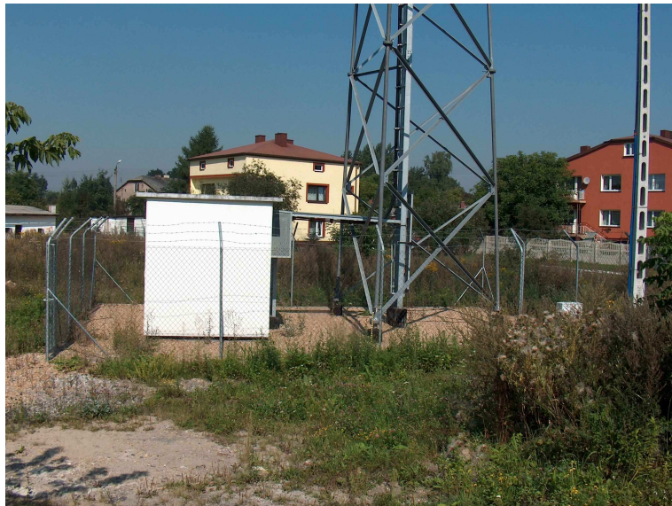
Fotografia Nr 8 Stacja bazowa telefonii komórkowej nr SB-08, ul. Łazowska – kontener z urządzeniami nadawczo-odbiorczymi.
