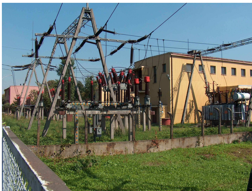
Fotografia Nr 56 Stacja rozdzielczo-transformatorowa 110kV/SN Chopin ST-04.
