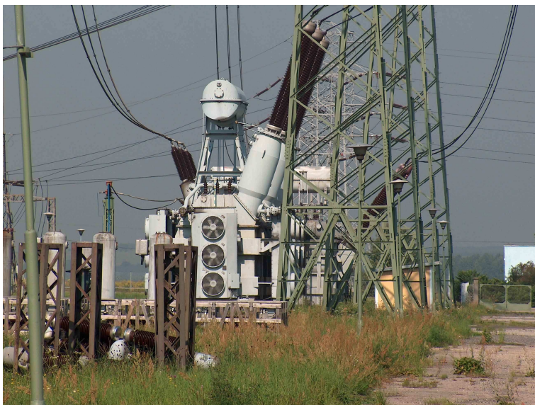
Fotografia Nr 41 Stacja rozdzielczo-transformatorowa 400kV/110kV Tucznawa ST-01 – dwa transformatory 400kV/110kV.
